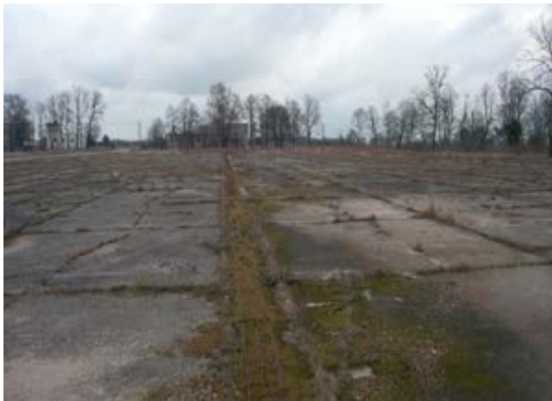
Stato della pista oggi
