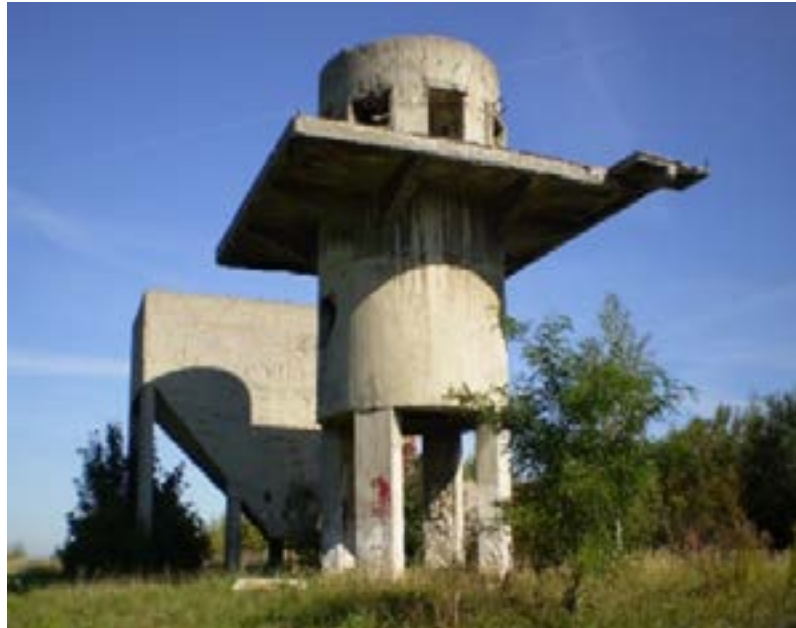
Resti della fabbrica
